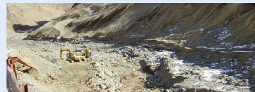
Maquinaria removiendo sedimento en el río Coya después del aluvión de 2008.
